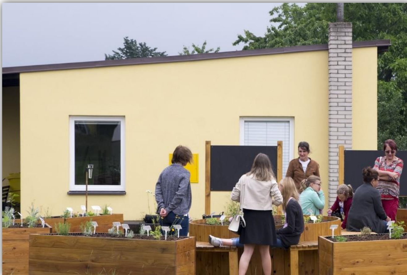
Zahradní domek - po rekonstrukci
