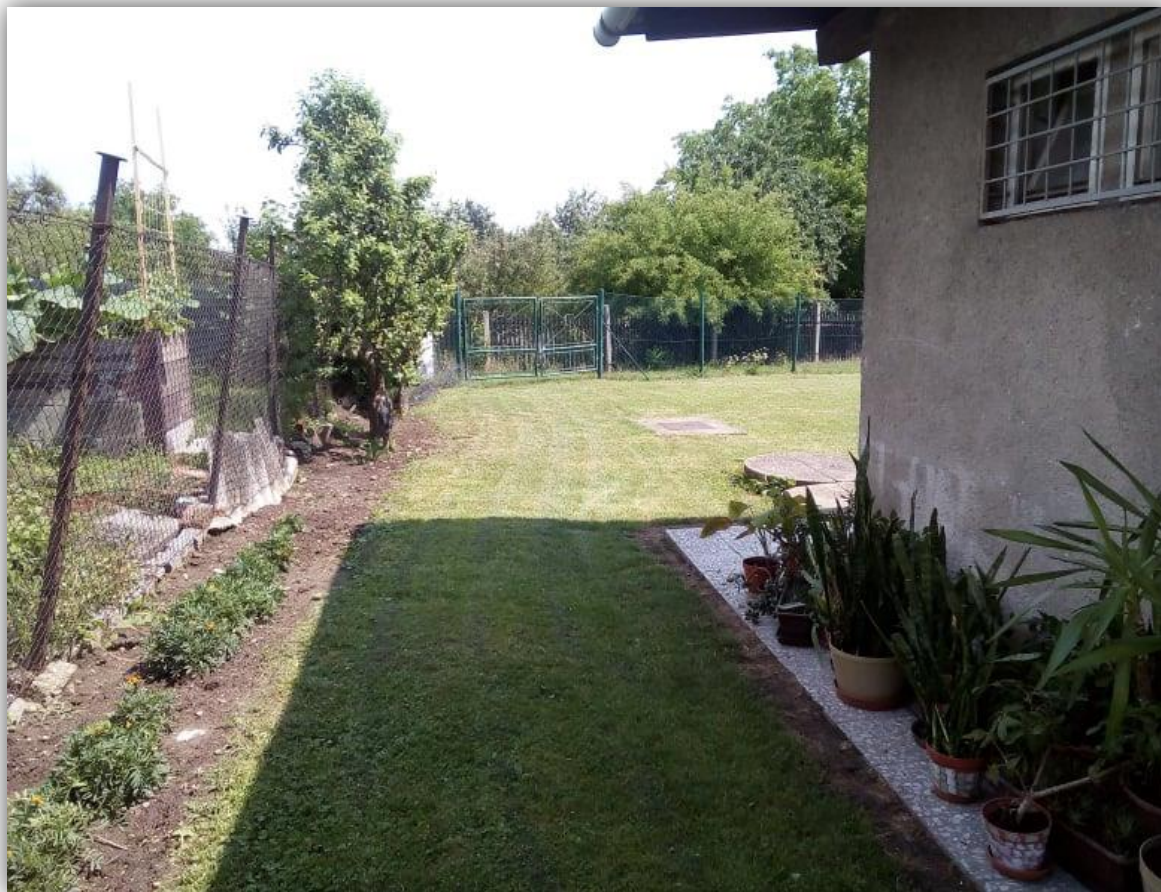
Zahradní domek - před rekonstrukcí
