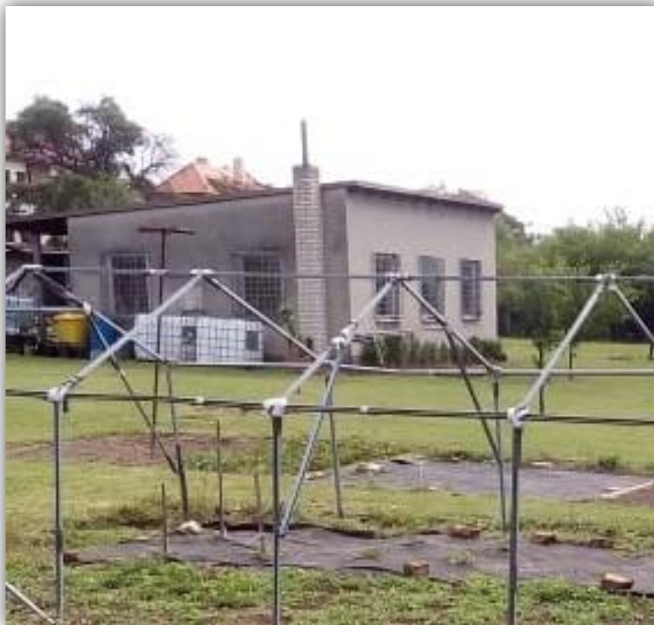
Zahradní domek - před rekonstrukcí
