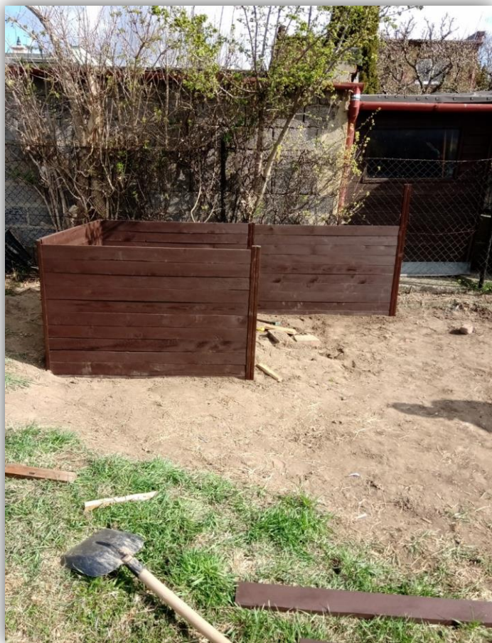
Výstavba nového kompostéru
