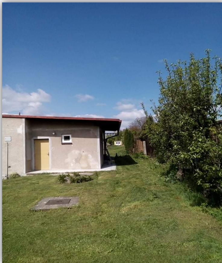
Zahradní domek v průběhu rekonstrukce
