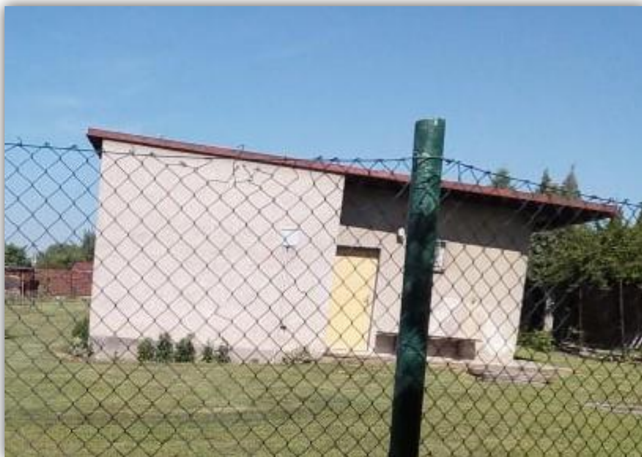
Zahradní domek - před rekonstrukcí
