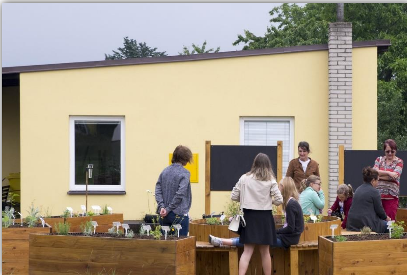
Zahradní domek - po rekonstrukci
