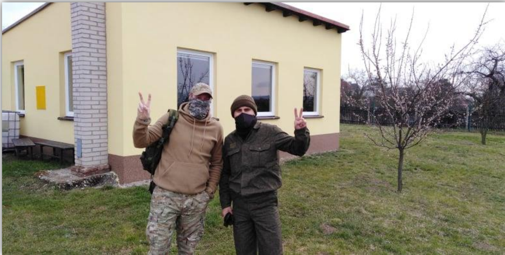
Zahradní domek - po rekonstrukci
