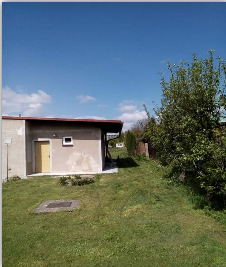
Zahradní domek v průběhu rekonstrukce
