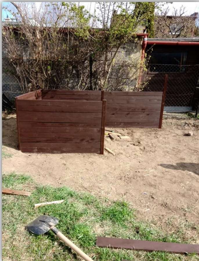
Výstavba nového kompostéru
