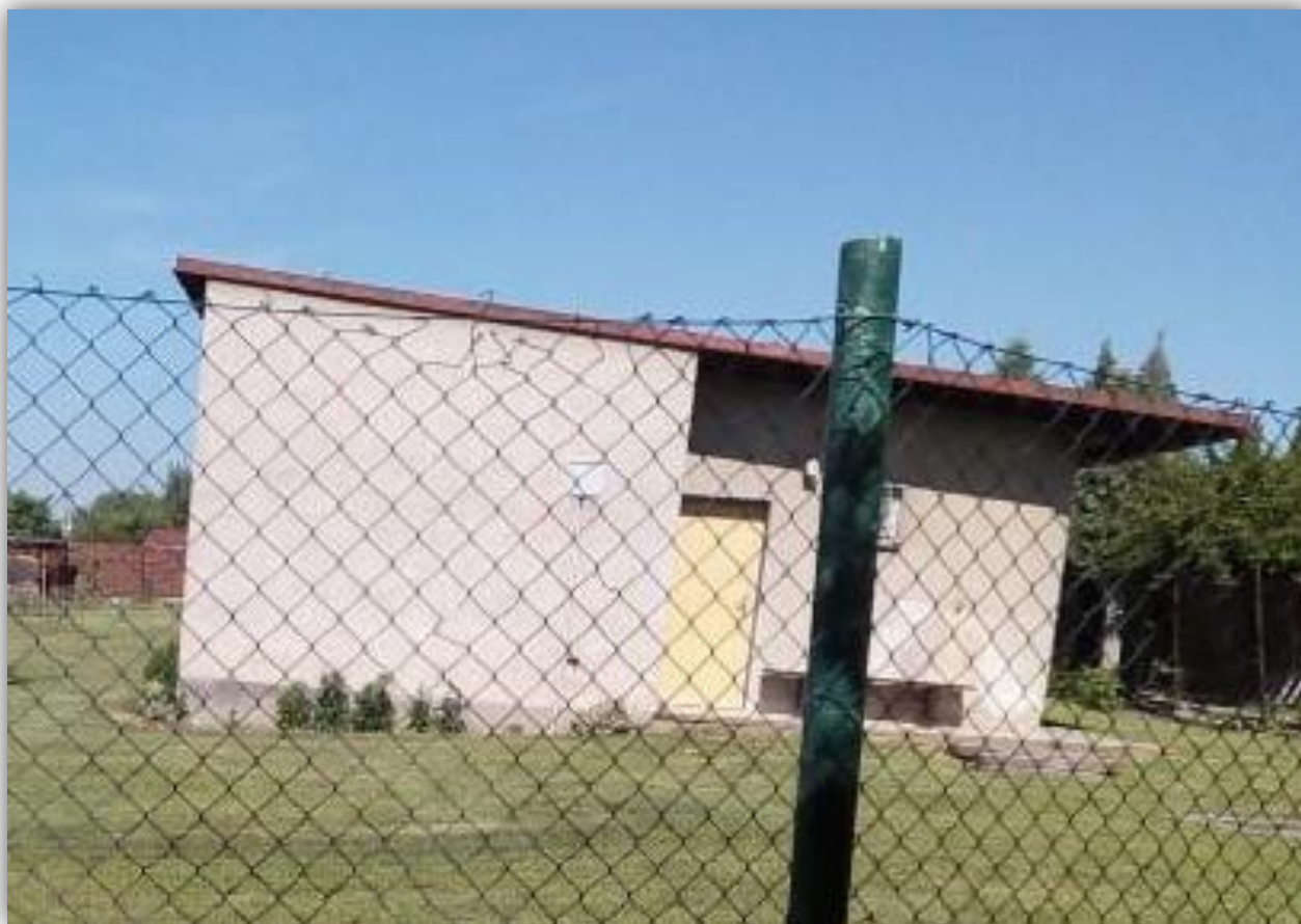
Zahradní domek - před rekonstrukcí
